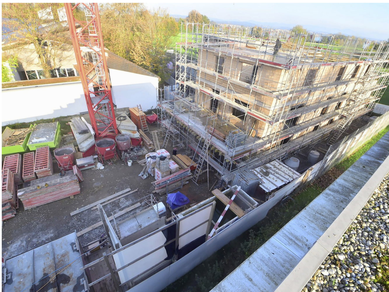
Der Bau des Flamingo Kinderhospizes in Fällanden ist schon weit fortgeschritten.
